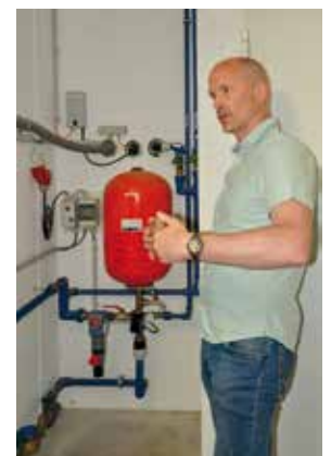
Die Eders beziehen das gesamte Wasser von einem eigenen Hausbrunnen. Um dieses ausreichend zu reinigen, wurde ein spezieller Filter eingebaut.
