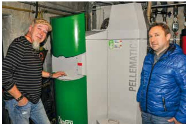
Andi fragt nach ob es normal ist, dass die Asche noch nicht entleert werden muss. Die Pelletsheizung verbrennt sehr effizient. Erfahrungswerte aus Wohnhausanlagen zeigten, dass die erste Entleerung erst nach etwa 6-8 Tonnen verbrauchte Pellets fällig wird. Rechtzeitig bevor der Behälter voll ist, meldet dies die Anlage vollautomatisch.
