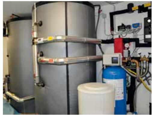
Die beiden Pufferspeicher haben ein Fassungsvermögen von 4.000 l und sorgen für ausreichend Warmwasser.
