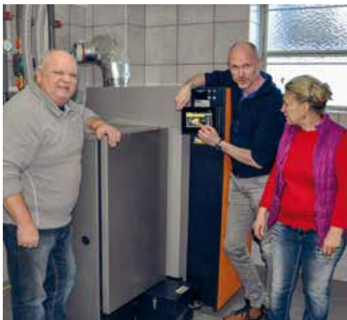
Mit dem ETA-Kombikessel kann man wahlweise mit Pellets oder Stückholz heizen.
