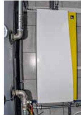
Das IDM-Frischwassermodul garantiert hygienisch einwandfreies Warmwasser.
