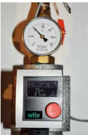
Die hocheffiziente Heizkörperpumpe reduziert den Energiebedarf deutlich. Da die Pumpe die volle Leistung nur dann bringt, wenn sie auch wirklich benötigt wird, ist eine Stromkostensparnis bis zu 60% möglich.
