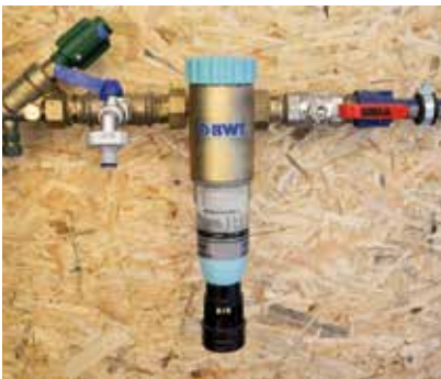
Schmutzpartikel im Wasser sind häufig die Ursache für tropfende Wasserhähne, verstopfte Ausflusssiebe, blockierende Ventile bei Haushaltsgeräten und ein erhöhtes Hygienrisiko. Der eingebaute Wasserfilter schützt das Rohrleitungssystem und sorgt für sauberes Trinkwasser.
