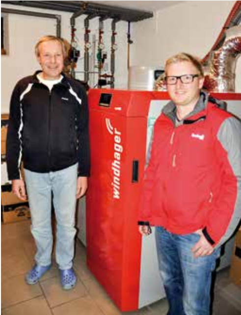
Techniker Martin Heiligenbrunner von Haustechnik Fichtinger stand dem Ehepaar beratend zu Seite. Manfred Bendl ist von der hohen Qualität des Kessels überzeugt.
